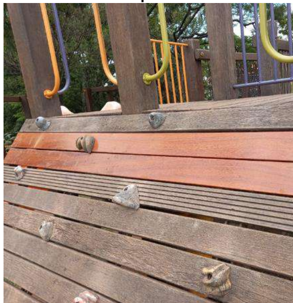
Figura 55 - Manutenção em playground - brinquedos
