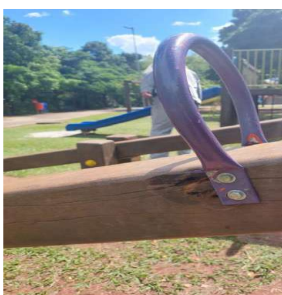
Figura 57 - Manutenção em playground - brinquedos
