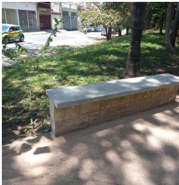
Figura 58 - Manutenção e pintura em bancos
