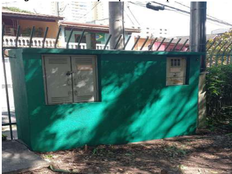
Figura 60 - Manutenção e pintura em quadro elétrico
