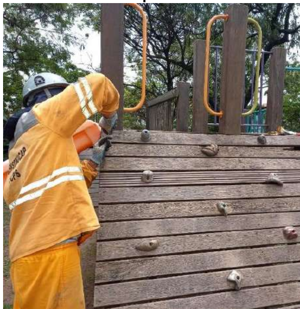
Figura 54 - Manutenção em playground - brinquedos
