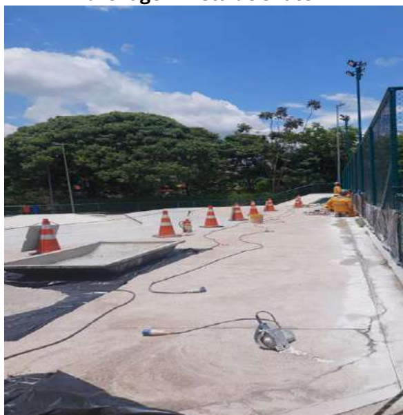
Figura 65 - Instalação de canaleta de drenagem Pista de Skate
