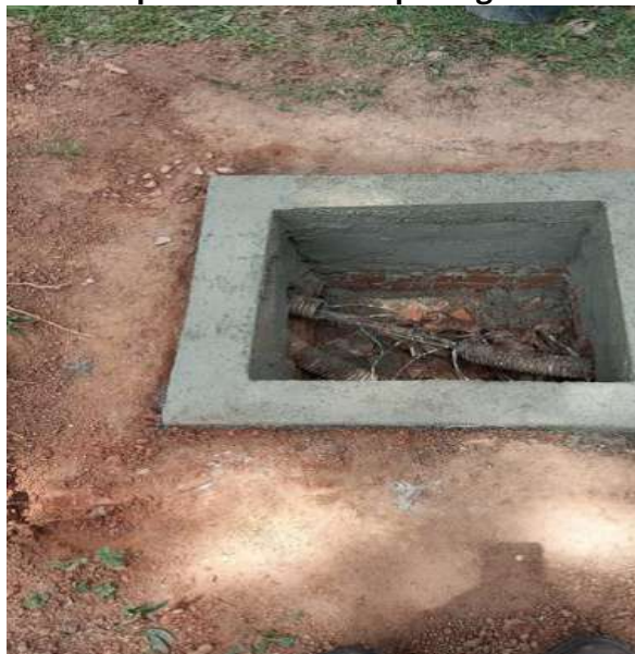
Figura 51 – Reforma, manutenção e limpeza de caixas de passagem
