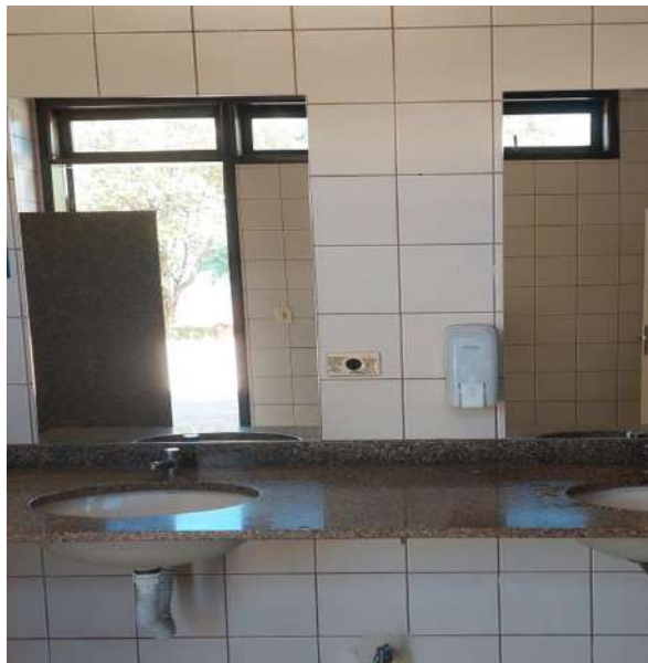
Figura 69 – Instalação saboneteiras e papeleiras
