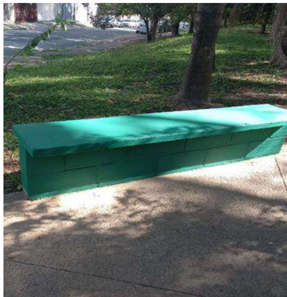
Figura 59 - Manutenção e pintura em bancos
