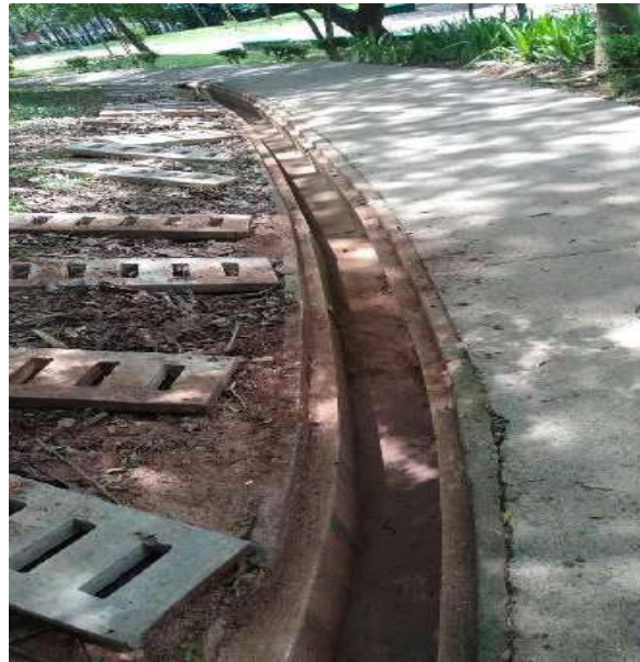
Figura 48 – Manutenção e limpeza de calhas
