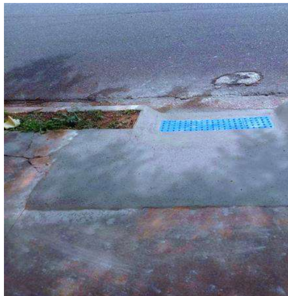
Figura 78 – Instalação de rampas acessíveis nas calçadas do parque
