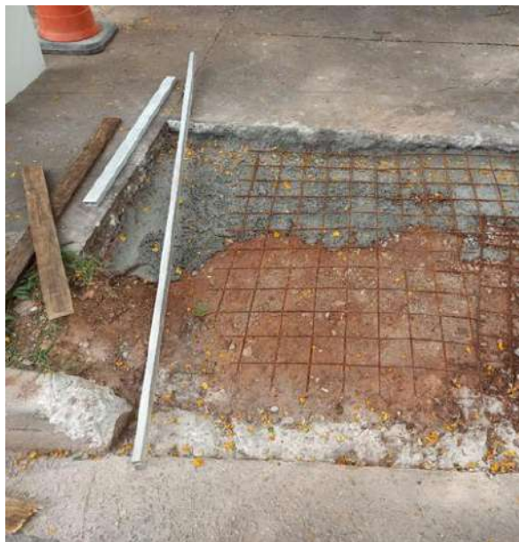
Figura 77 – Instalação de rampas acessíveis nas calçadas do parque
