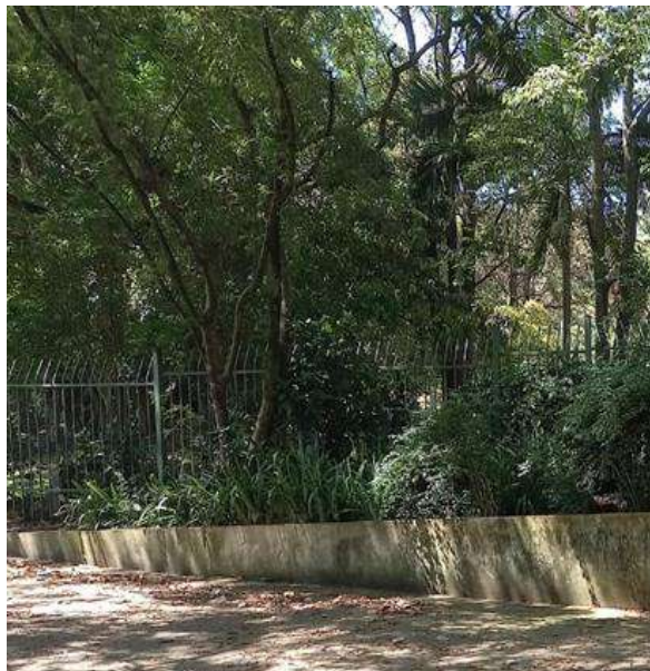
Figura 61 – Manutenção e pintura de muretas
