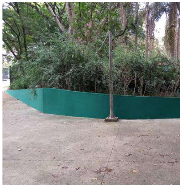
Figura 62 – Manutenção e pintura de muretas
