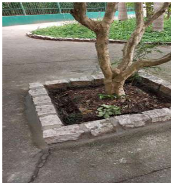
Figura 64 – Instalação de canteiro
