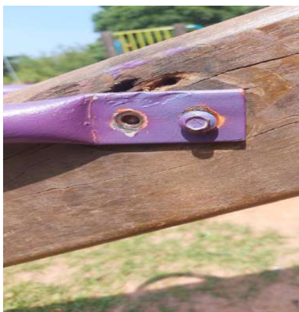
Figura 56 - Manutenção em playground - brinquedos
