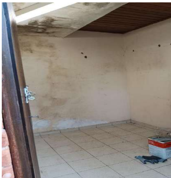
Figura 71 – Manutenção e reforma de almoxarifado
