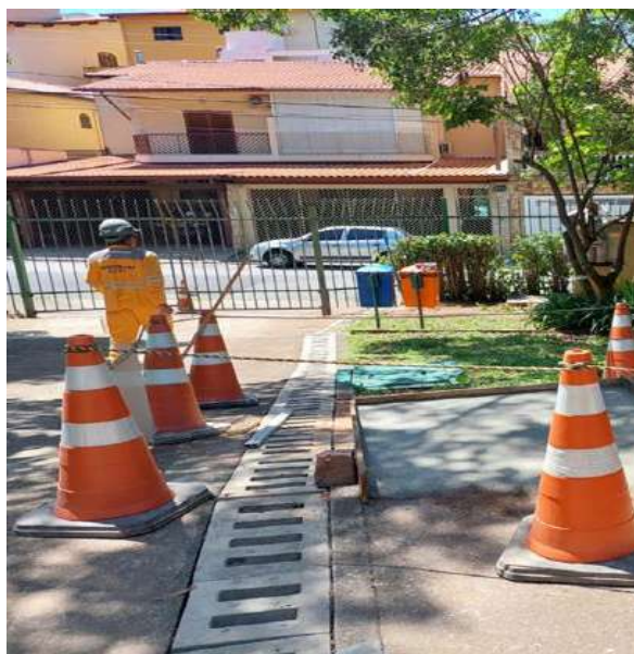
Figura 75 – Instalação de piso para nova guarita
