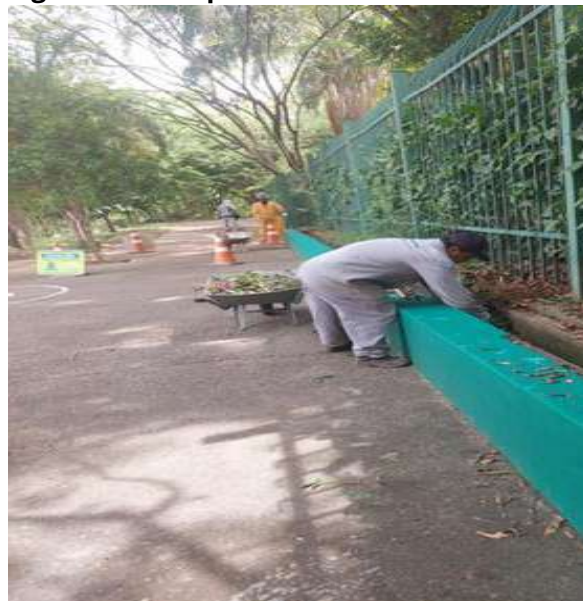
Figura 15 - Limpeza de canaletas
