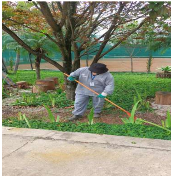
Figura 14 - Reforma de canteiros
