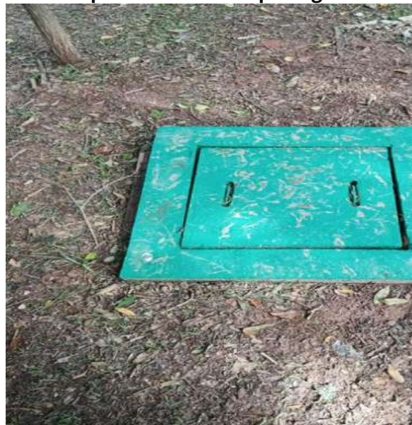
Figura 52 – Reforma, manutenção e limpeza de caixas de passagem
