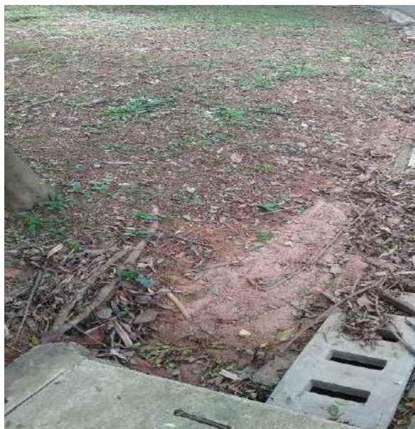
Figura 47 – Manutenção e limpeza de calhas
