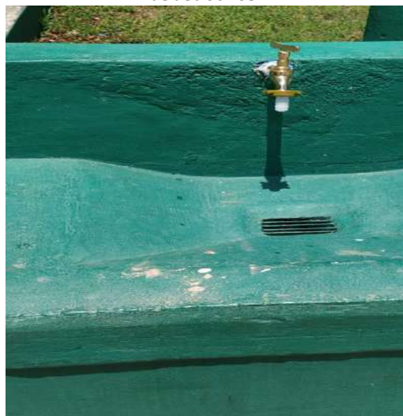
Figura 66 - Manutenção e pintura de bebedouros
